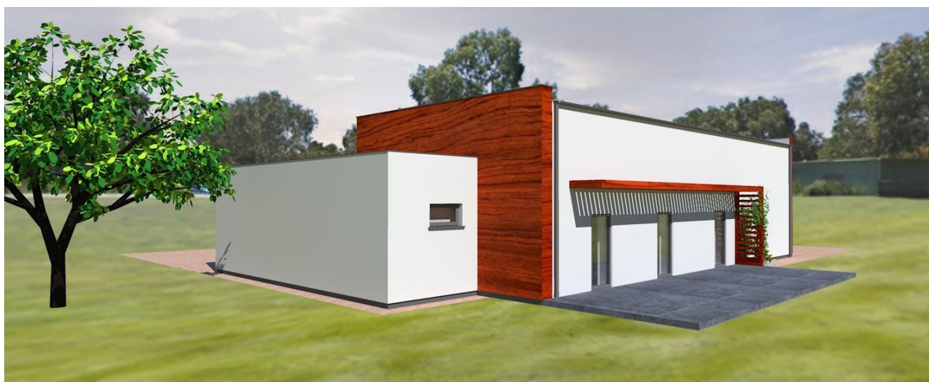
Widok od strony północno – zachodniej
